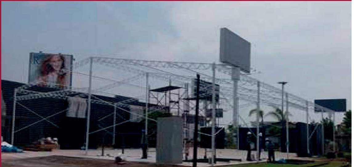
Almacén de Producto Yamaha - Techo Metálico
