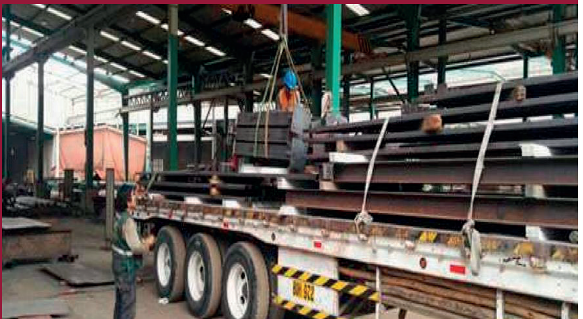
Ampliación Refinería Talara - Petroperu
