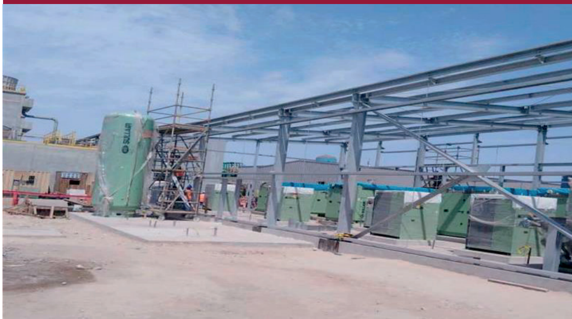
Sala de Compresores Aceros Arequipa - Techo Metálico
